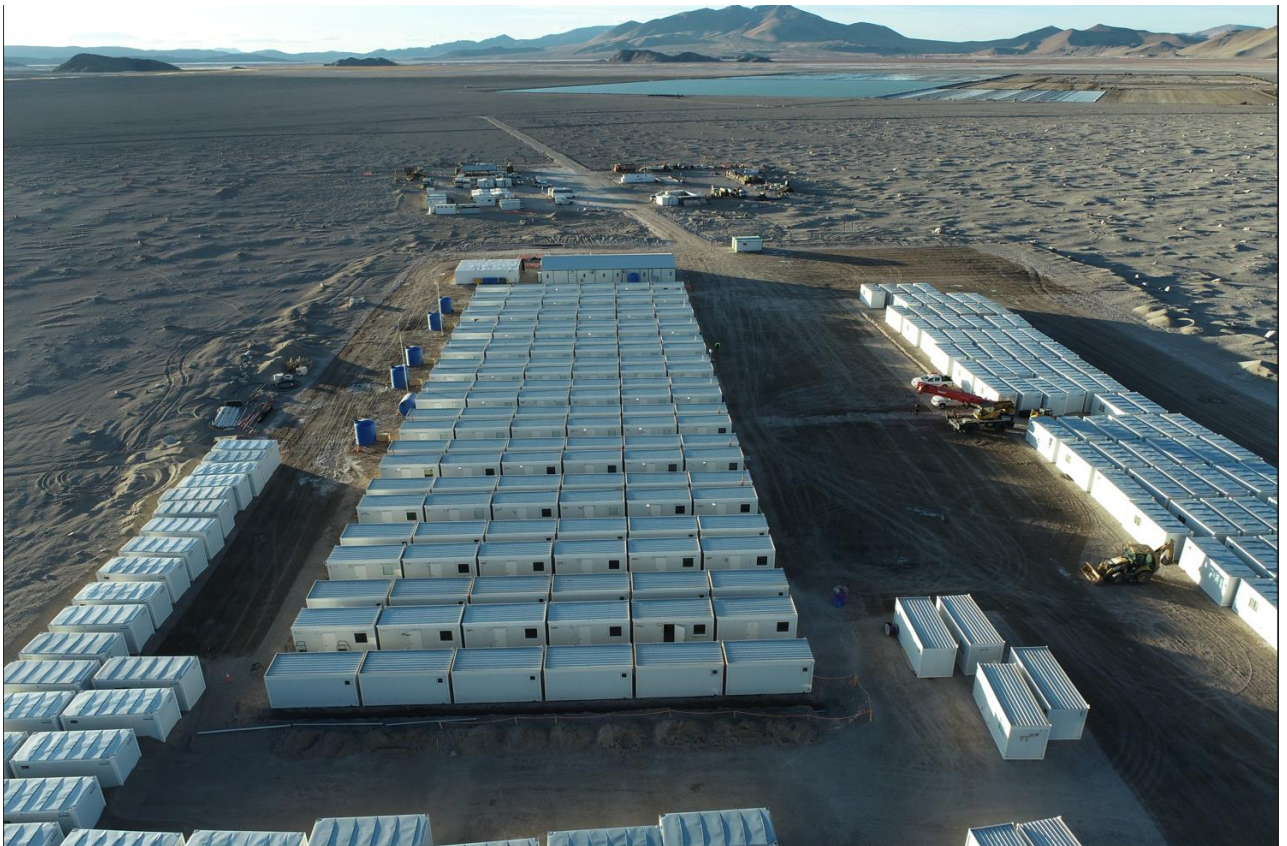
Foto III-3. Campamento de construcción (temporario).
