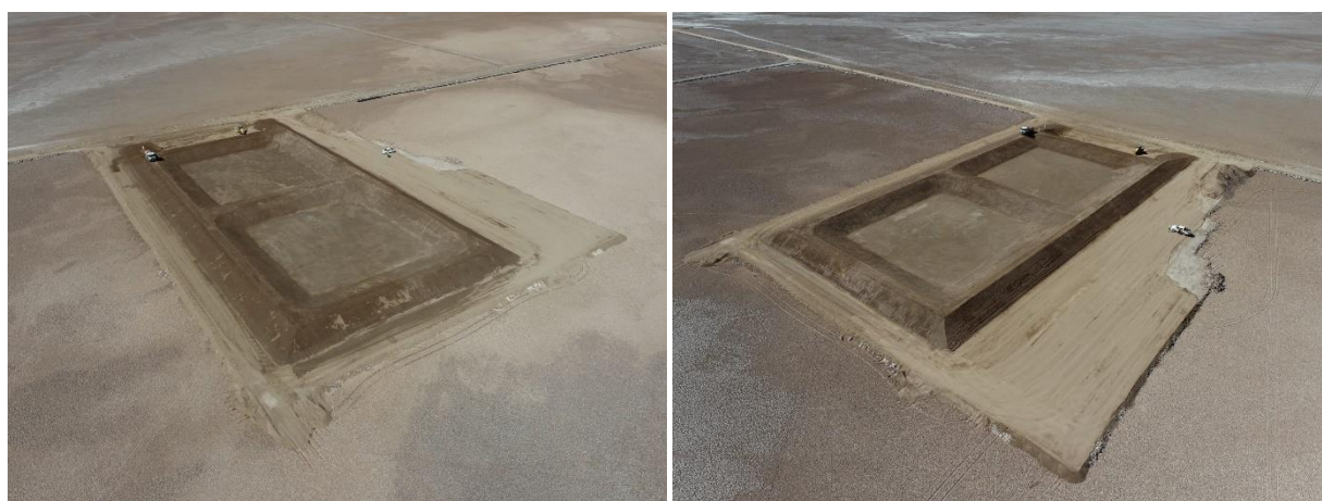
Foto II-61. Vista de la estación de rebombeo en construcción sobre el salar.
