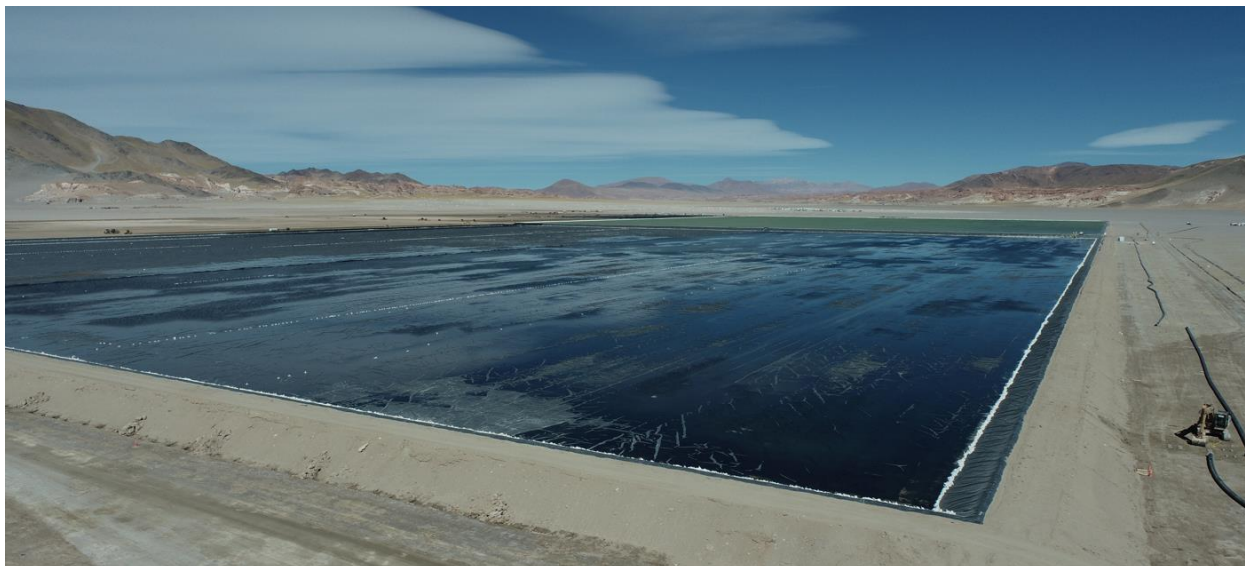
Foto III-1. Impermeabilización de piletas H11 y H12 (julio 2022).
