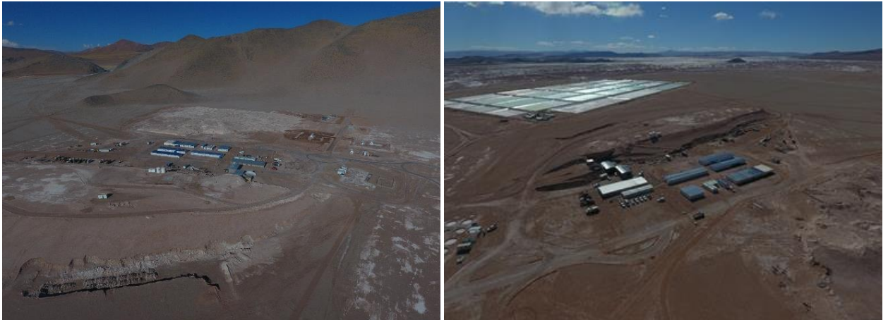
Foto II-57. Vista del campamento y piletas, hacia noroeste al fondo se observa el salar.
